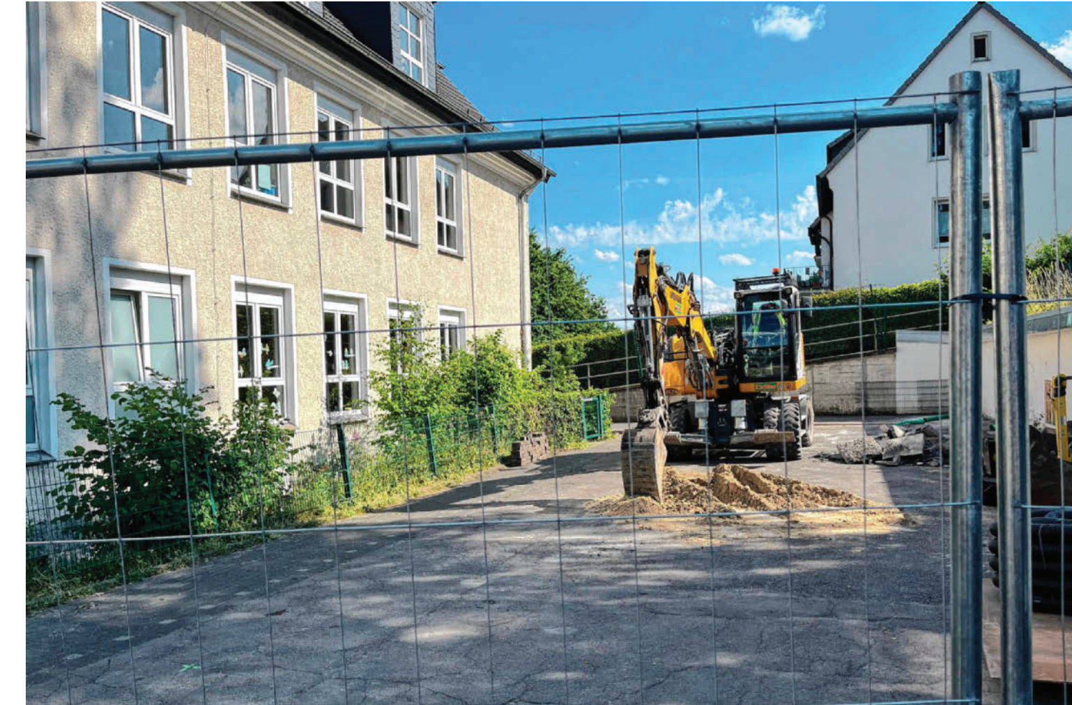
Die Vorbereitungen für den OGS-Ausbau an der Johannesschule haben begonnen.
