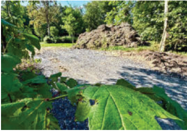
Die ersten Vorbereitungen für den Rückbau sind bereits getroffen.
